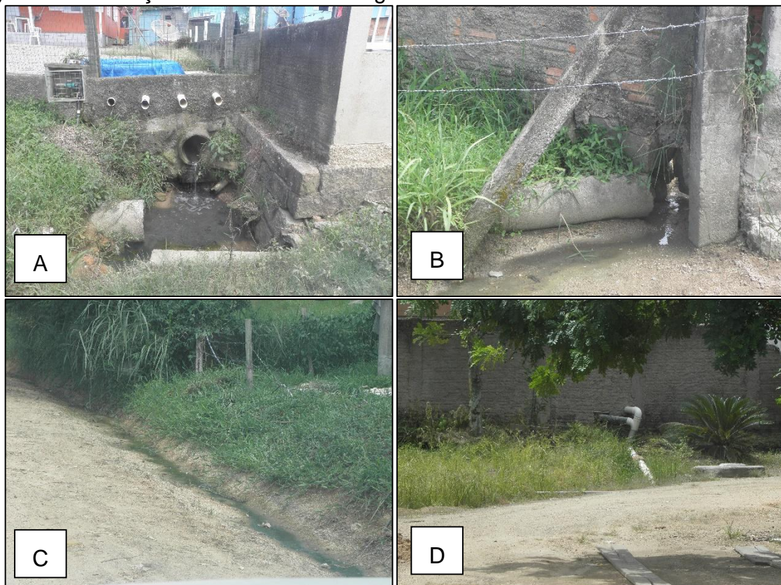
Figura 87 – Situações de descarte de esgoto a céu aberto.
