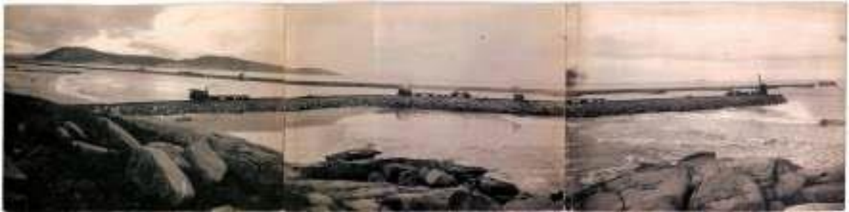
Figura 42: Construção dos molhes para melhorar o acesso ao porto, 1900.
